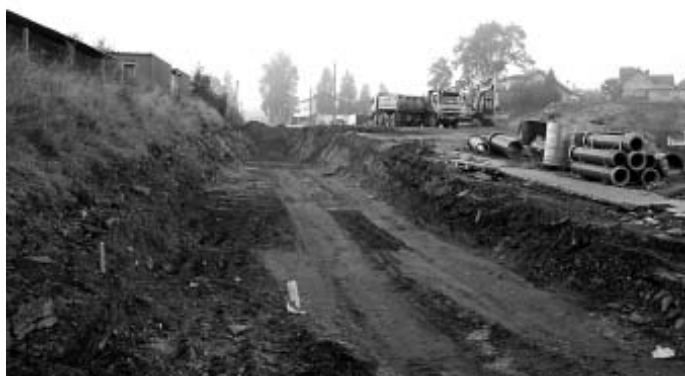
Rýha pro budoucí základy, v této části výkopu se našlo 6 kmenů.
