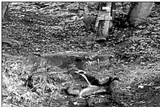
Vývěr ze štolý Zechanmühle nad Stupnou
