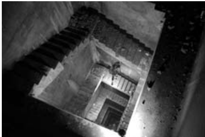
Schodiště k dělové otočné věži
