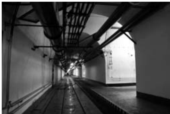
Hlavní galerie s dvojkolejnou tratí u muničních sálů
