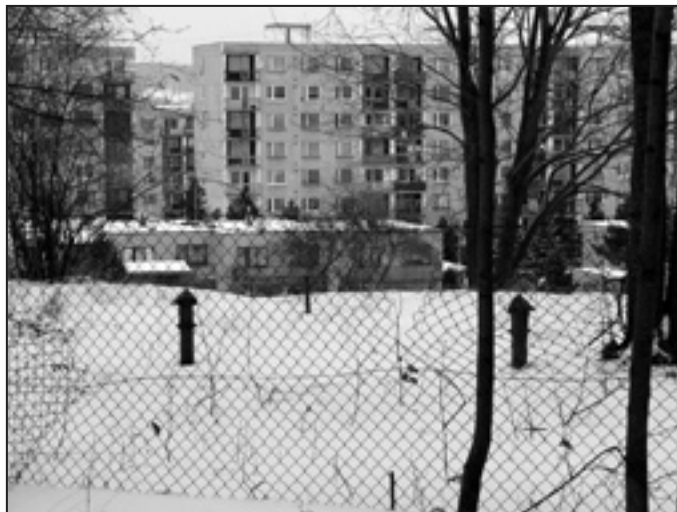
Větrací komínky na stropnici objektu
