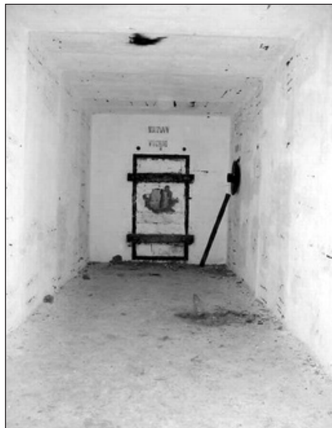
Hlavní úkrytová místnost
