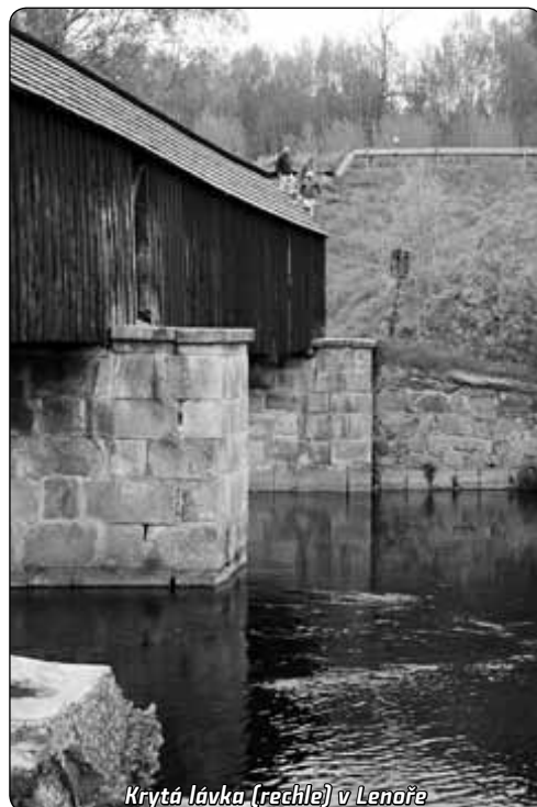
Krytá lávka (rechle) v Lenoře
