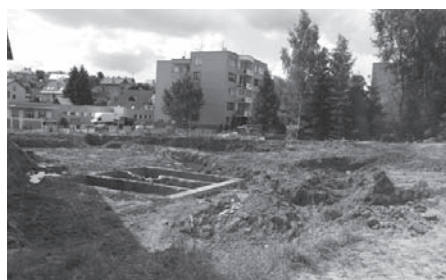
Stavební jáma pro Novopacký bazén
