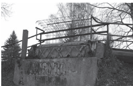
Betonový základ jedné z opěr původní lávky
