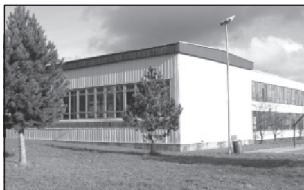
Stará nevyhovující tělocvična
