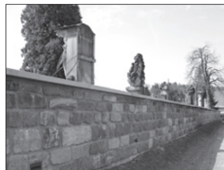
oprava hřbitovní zdi.
