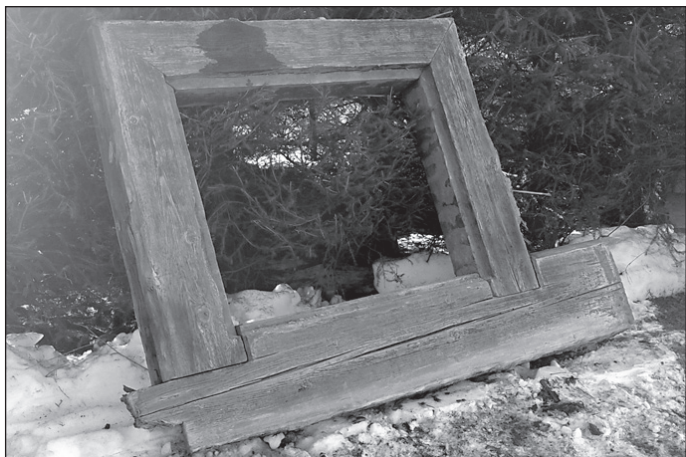
14. února 2017 zachráněné původní okno, další části se podařilo zachránit B. Benčovi a P. Jeriemu v průběhu demolice. Uloženy budou v Městském muzeu foto: Bohuslav Benč
