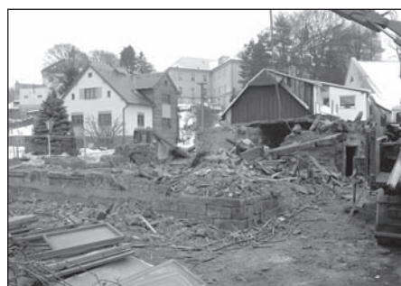
10. února 2017 demolice je téměř dokončena
