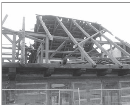
7. února 2017 vazba střechy byla v dobrém stavu, je možné vidět na řezu
