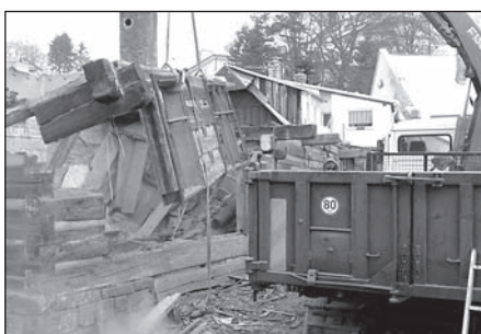
9. února 2017 jednotlivé stavební prvky jsou velmi dobře spojené, musí se řezat
