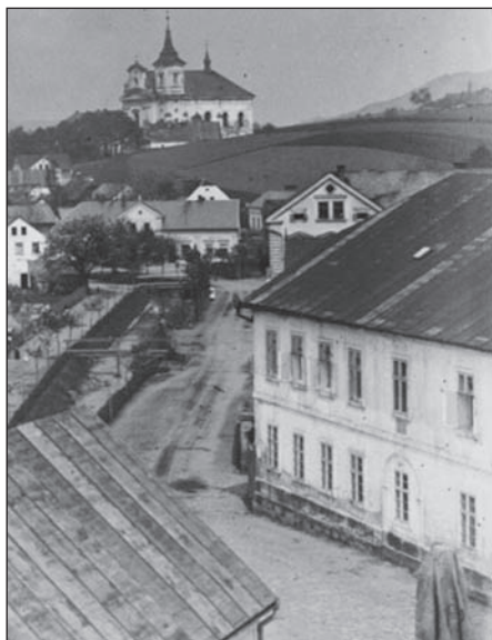
Nová hospoda (č. p. 247) byla v roce 1817 (před 200 lety) přestavěna majitelem Janem Valáškem, který vybudoval v prvním poschodí velký sál určený pro divadlo a taneční zábavy. Nová hospoda (budova vpravo)
