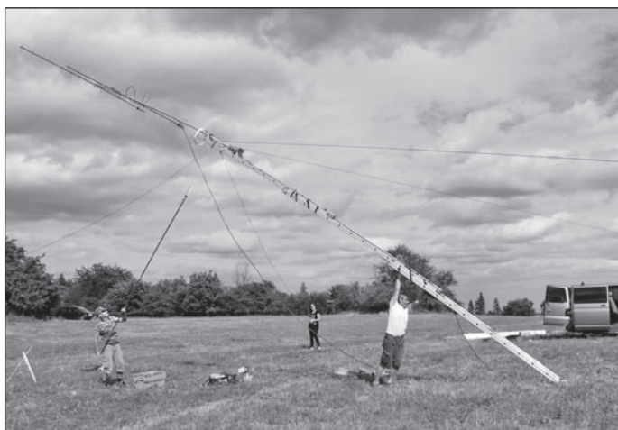
Vztyčování „žebříkostožaru“ se soustavou antén
