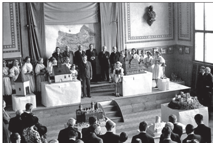
Celkový pohled na pódium
