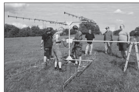
KMP 02 Montáž anténní soustavy na 432 MHz před závodem
