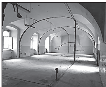
Sál v rekonstrukci
