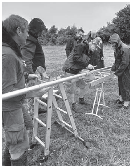
Stavba stožárů za deštivého počasí
