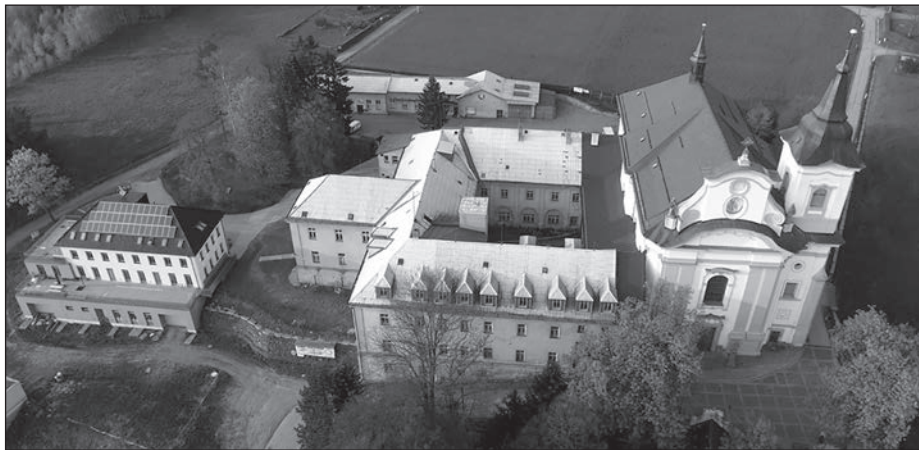
Celkový pohled před rekonstrukcí
