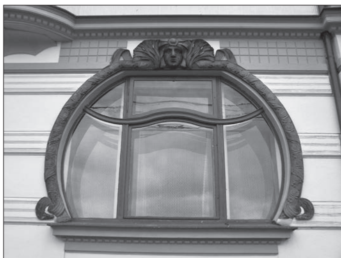
Sudová okna z roku 1908
