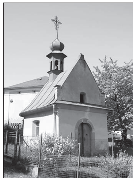
Kaple před opravami. Foto OA autora
