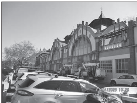
Vodní elektrárna Hučák
