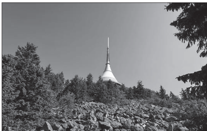
Kameny pod Ještědem
