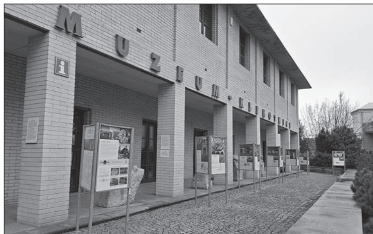
Výstava Má vlast cestami proměn instalovaná před budovou klenotnice
