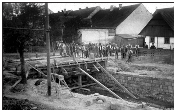
Stavba mostu na Jiráskově nábřeží
