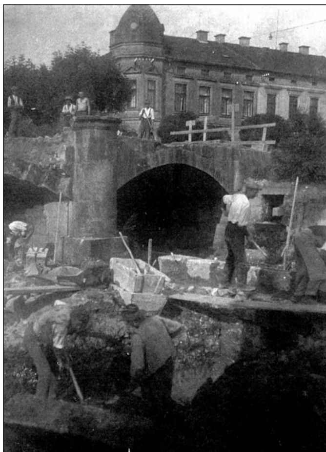
Bourání původního mostu
