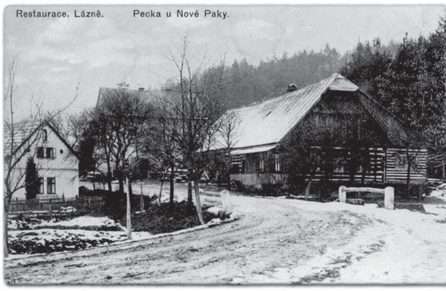
Vlevo budova lázní, vpravo Jindrákův hostinec a za ním hospodářství rodiny Pátých
