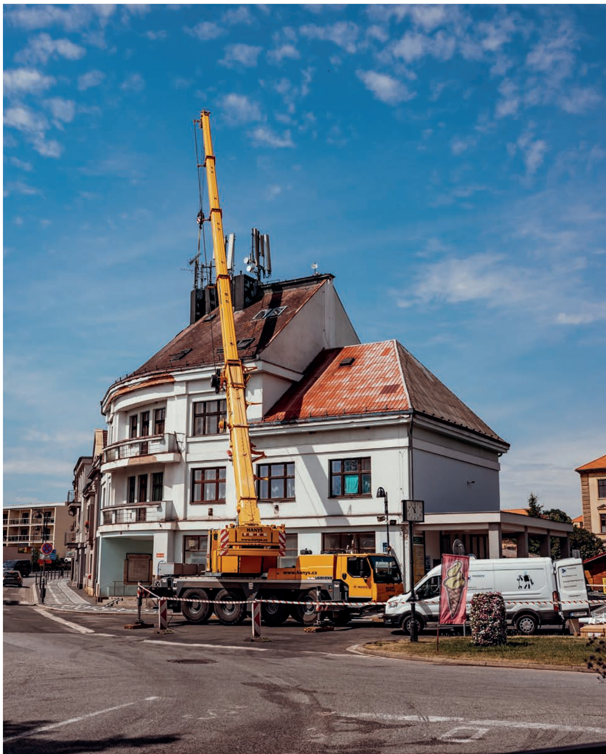
Údržba vysílače na bývalé spořitelně, foto: Roman Kunčík
