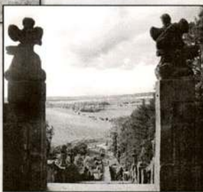
Výhled ze schodiště s částí schodiště zachovanou výhledem sošek andlíků a váz. 90. léta 20. století.
