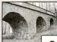
Ponechání oblouků schodiště. 2006.
