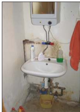
Původní stav nevyhovujícího sociálního zařízení: umyvadlo bez obložení s odkrytým vodovodem a suchý záchod, který hrozil zřícením.
