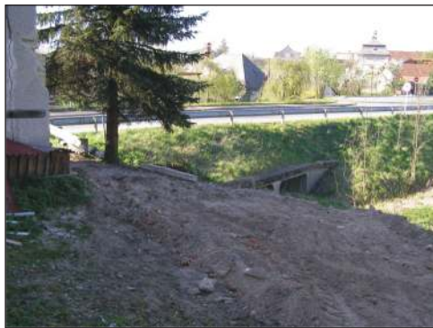
Současný stav: přístavba byla zbourána v listopadu a v dubnu byla odstraněna zadní část rampy. Přední část bude rozebrána po okrskové soutěži.
