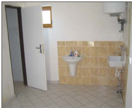
Současný stav sociálního zařízení: nový dřez na mytí nástrojů, nové umyvadlo na ruce, bojler, obložení a nové WC
