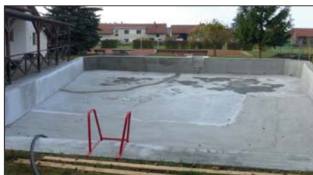
Požární nádrž Rájec po opravě.
