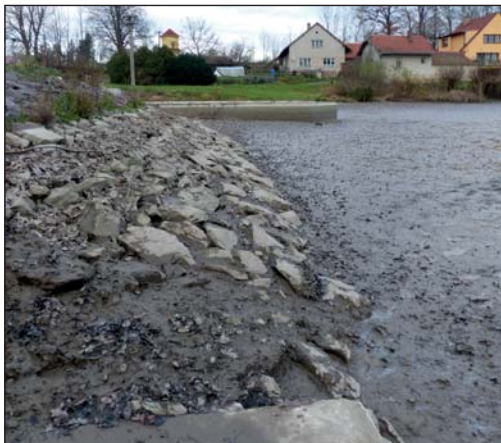
Bytelná hráz Horního rybníka má na návodní straně kamenný obval.
