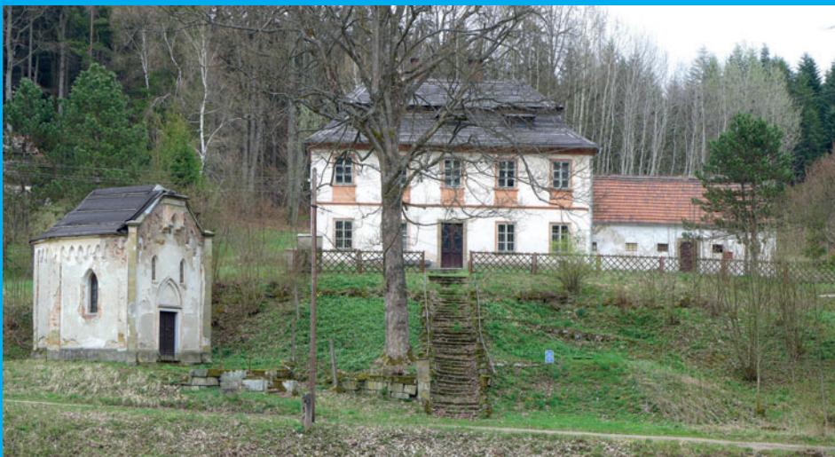
Kaple, schodiště a lovecký zámček - stav v dubnu 2016
