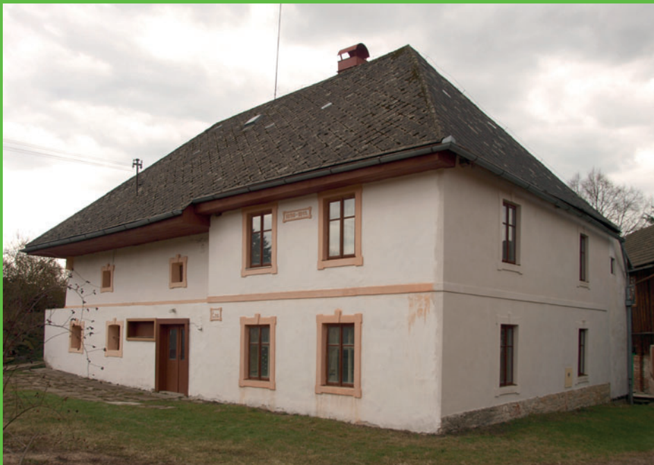
Mlýn v Přestavlkách - čp. 20
