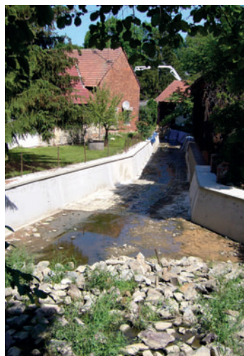
Zpevňování břehů potoka v Přestavkách - r. 2017
