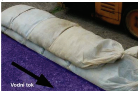
Jednořadé kladení pytlů podélně
