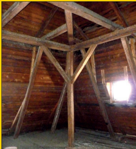
Dvě stě let stará tesařská práce, stolice nesoucí střechu je obdivuhodným dílem starých řemeslníků.
