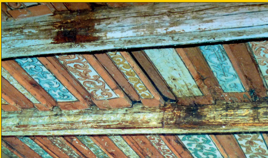
Malované zaklopení stropu bývalé společenské místnosti zakrylo novodobé obložení.
