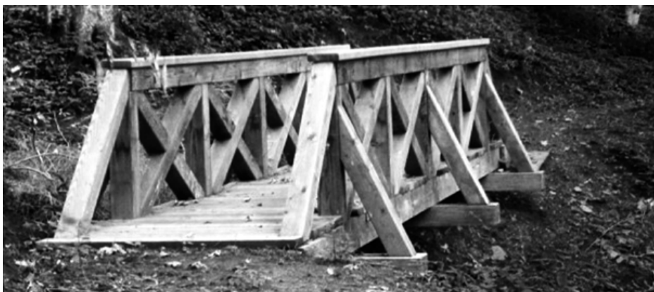
28. 10. 2010 byla nad mlýnem zahájena výstavba stezky, která měla vést k Ráji, ale neveď nikam. Byly tu postaveny dva pěkné dřevěné mostky. Myslím, že by stálo za to zjistit, kdo to nechal postavit a proč. Určitě to něco stálo, kdo to asi financoval? Už skoro rok se tu nic neděje. Bydlím kousek od této stezky a na dotazy turistů, kteří se ptají, kam stezka vede, dávám stále stejnou odpověď: Nikam. Načež si všichni mostky vyfotí, zakroutí hlavou a odcházejí. Že by Kocourkov? (Langer)
