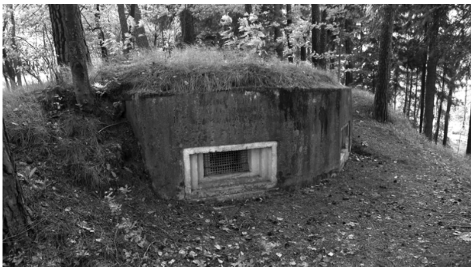
Objekt lehkého opevnění na Pasech nad odbočkou na Jetřichov
