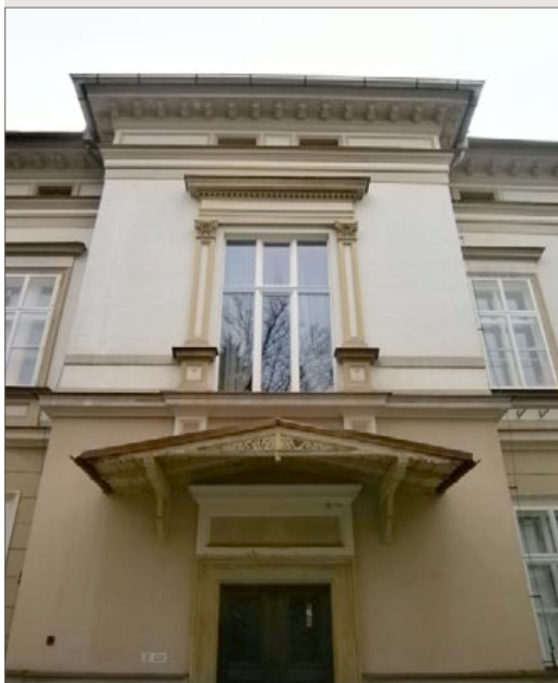
Repase a výměna oken na budově MěÚ
