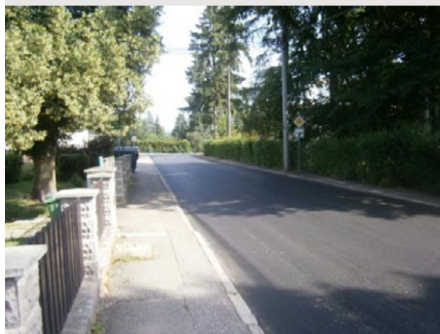
Obnova vozovky a chodníků v Provaznické ulici
