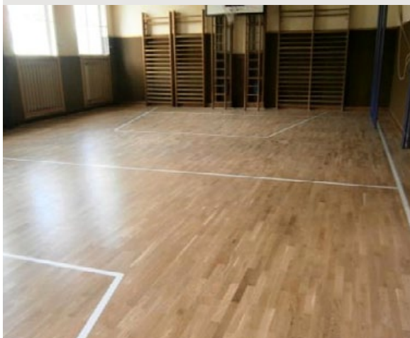
Oprava podlahy tělocvičny v ZŠ Masarykova
