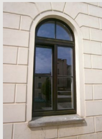
Výměna oken na ZŠ Hradební
