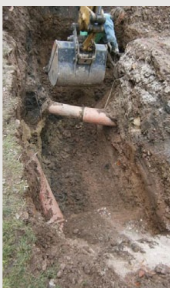
Oprava kanalizace v Lidické ulici
