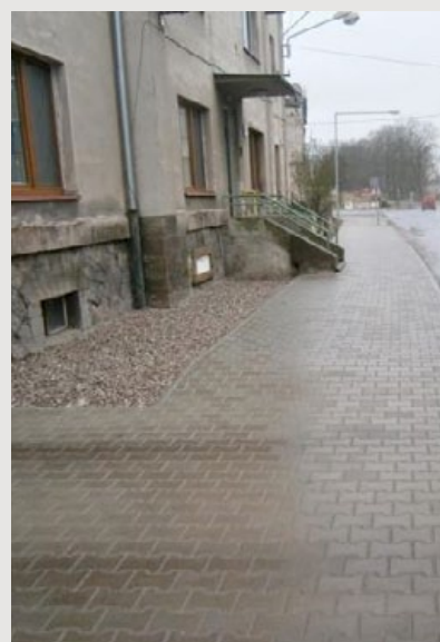
Oprava chodníků v Alšově ulici
