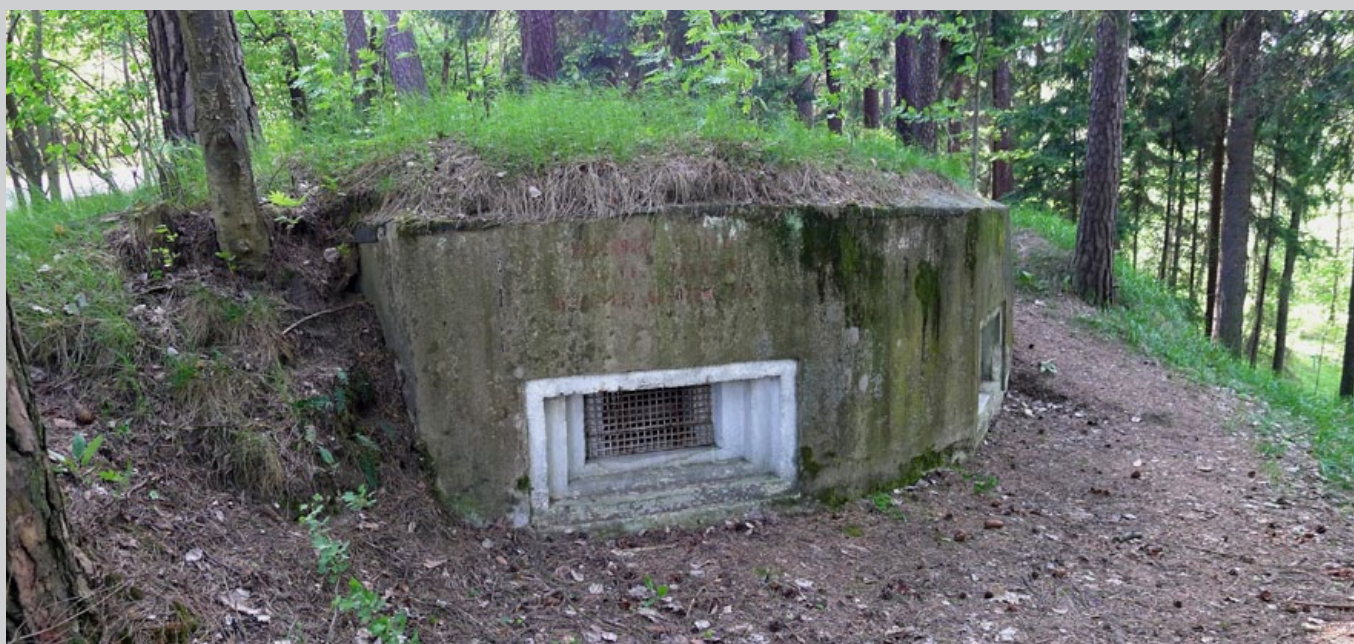
Bunkr lehkého opevnění z roku 1936 nad jetřichovskou křižovatkou.
