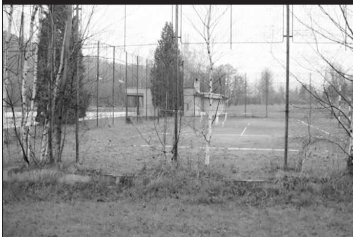
Víceúčelové hřiště v Olivětíně 2013 – stav před zahájením prací, částka: 830 tis. Kč - z toho dotace 620 tis. Kč z programu Leader (SZIF)
