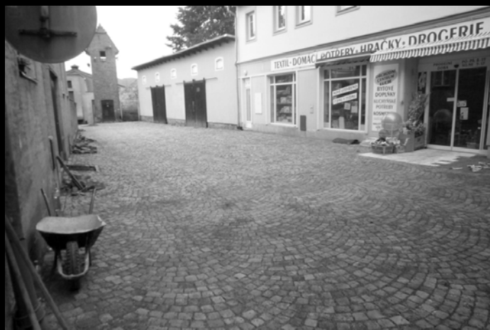
MK Máchova u trafostanice, částka: 273 tis. Kč (vlastní kostky)
