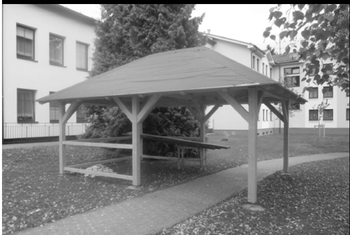
Altán pro domov důchodců, Jiráskova 193 - náklady na tesařské práce cca 85 tis. Kč, předpokládaný náklad na dláždění 25 tis. Kč. Spolufinancováno Podnikatelským klubem Broumov.
