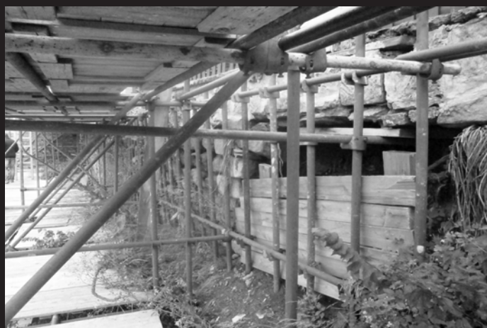
Oprava části zdi městských hradeb, Broumov, p.č. 141/5. Stavba byla zahájena dne 23.9. 2013, částka: cca 820 tis. Kč
