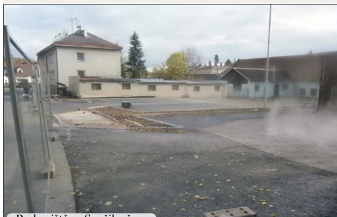
Parkoviště na Spořilově
