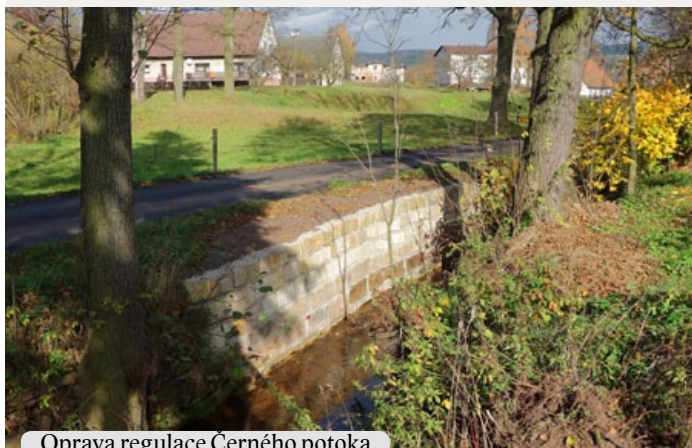
Oprava regulace Černého potoka
