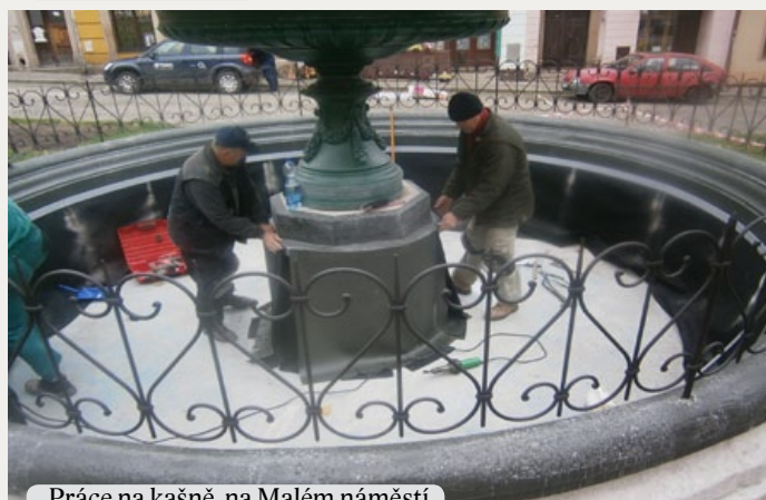
Práce na kašně na Malém náměstí
