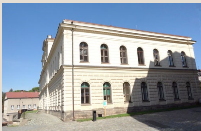
ZŠ Hradební - výměna oken
