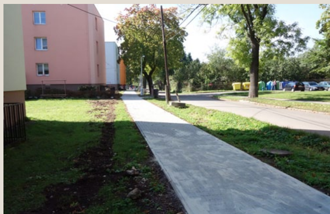
Křínická ul. - chodníky
