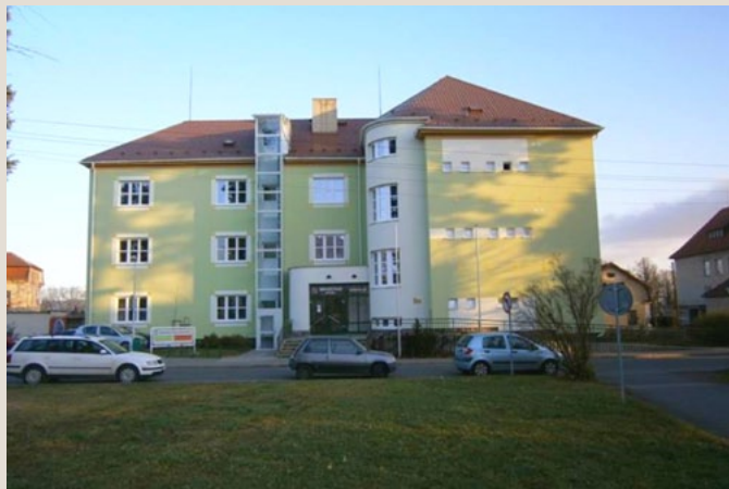
Městský úřad - Budova III
