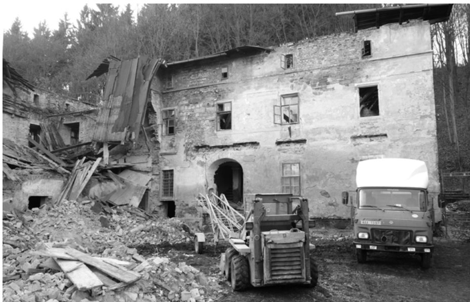
Demolice mlýnu po Černou stezkou - stav v roce 1213. Jak píše pan Obst ve sloupku Víte, že, práce na demolici spočívaly ve vylámaní a odvozu pískovcových architektonických článků historického objektu. Tím veškerý zájem majitele o objekt skončil.
