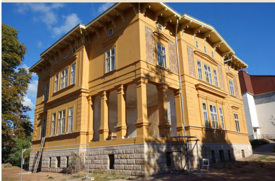
Renovace budovy Ulity
