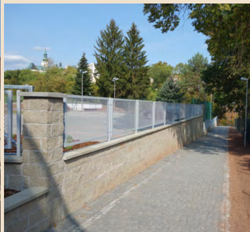
Úpravy cesty od Novákova mostu k Alejce
