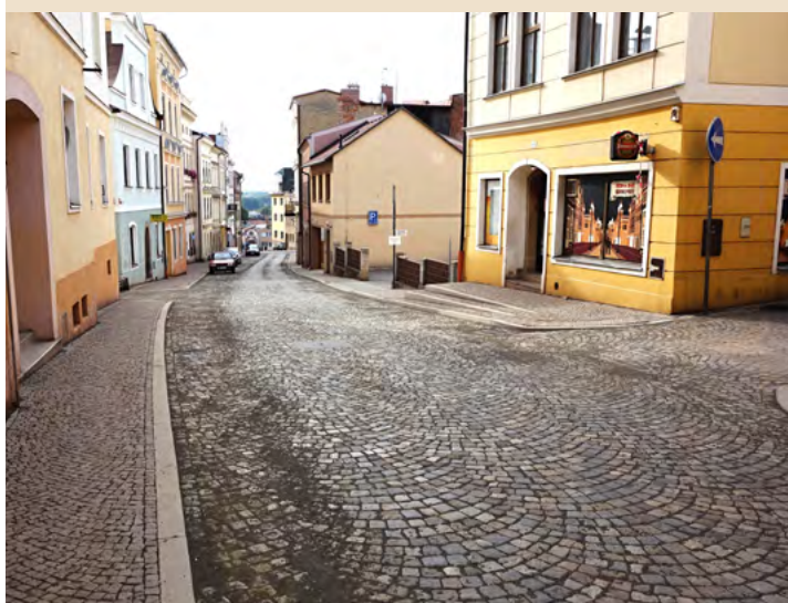
Obnova vozovky v ulici Obránců míru
