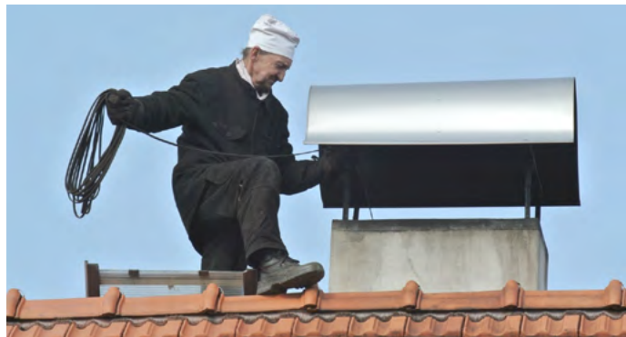
Revizní technik spalinových cest František Jaroš v akci Verněřovice, březen 2015.
