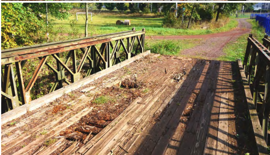
Mosty na Stěnavě - pod Hobrou a v Olivětíně
