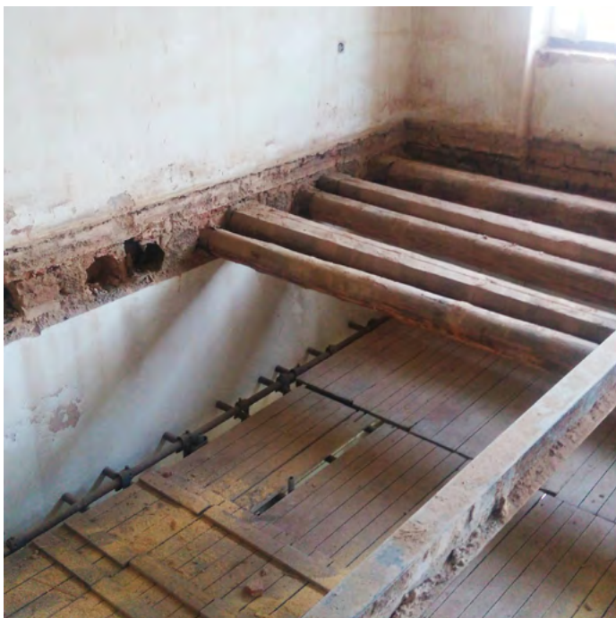
Výměna stropních konstrukcí v bývalé Herzogově kavárně
