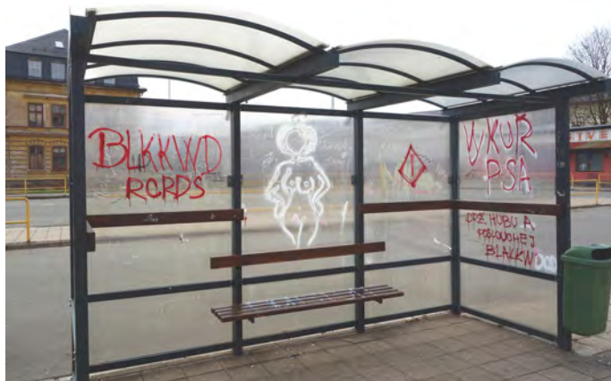
Dvě ukázky řádění vandalů na autobusovém nádraží
