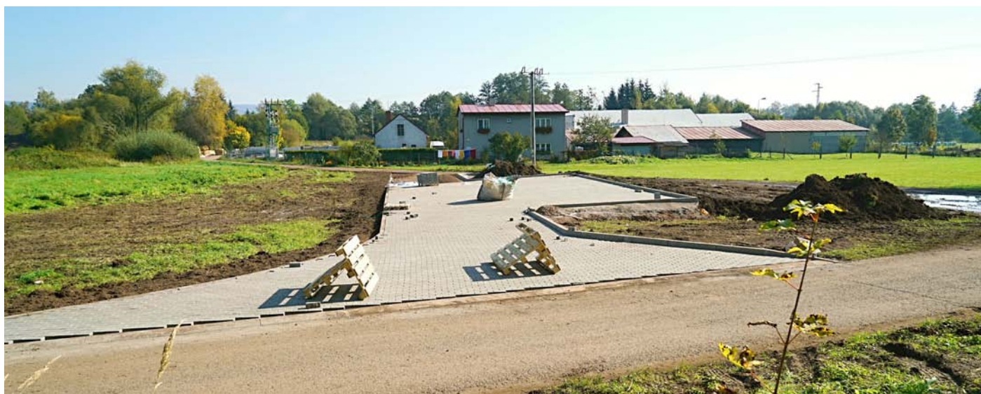
Stavba parkoviště na začátku cyklostezky
