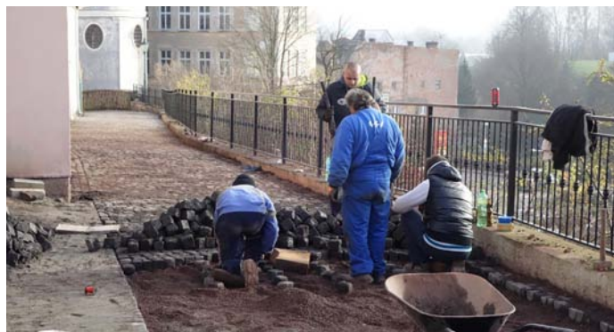
Výdlažba dolní části Máchovy ulice
