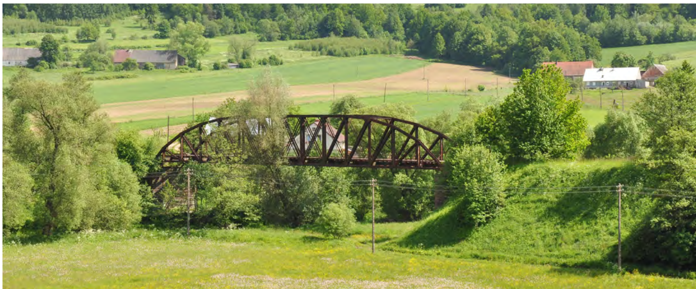
Železniční most v horním Tlumačově, na zrušené trati z Tlumačova do Otovic
