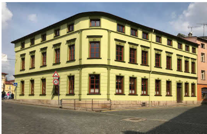
Pohled na dům U Horní brány 29, po rekonstrukci v roce 2018. Díky citlivým zásahům a zdařilé rekonstrukci se tak opět DŮM U HORNÍ BRÁNY 29 stal skvostem města Broumova.
