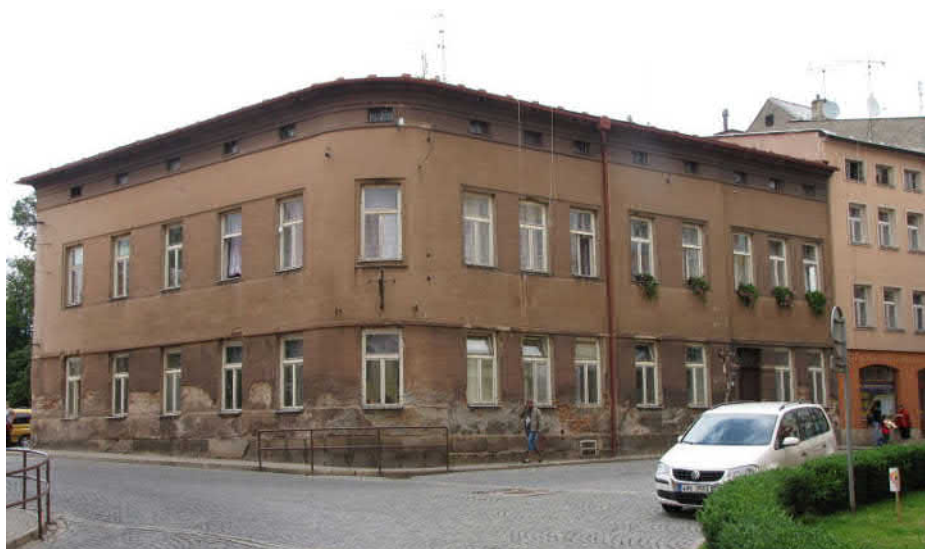
Pohled na dům U Horní brány 29, před rekonstrukcí. Původní členění fasád bylo nahrazeno v roce 1933 pouze plošným rámováním a kdysi bohatě zdobená fasáda byla po roce 1935 silně zjednodušena.
